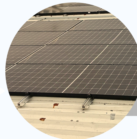
Izgradnja solarne elektrane Atom Vitez snage 80 kW po principu “ključ u ruke”
